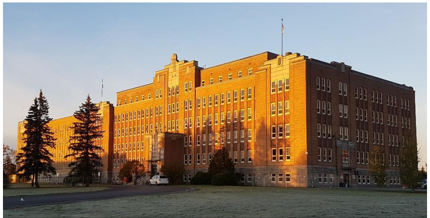
Le déficit d'entretien comprend la réfection du revêtement de brique du Carrefour du savoir Harricana, construit en 1940, qui doit être changé au coût de 10 000 000 $. Le ministère vient d'autoriser l'évaluation par des professionnels de cet investissement majeur.
